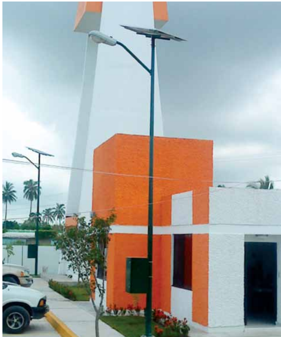
En las instalaciones de la Marina, para abastecer la necesidad del alumbrado público, se usan celdas fotovoltaicas o solares.
