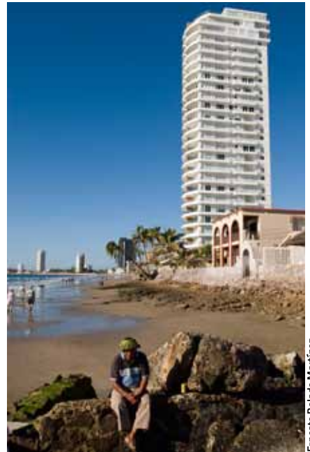
La construcción sobre dunas costeras pone en riesgo la infraestructura debido al incremento del nivel del mar y la erosión de las playas.
