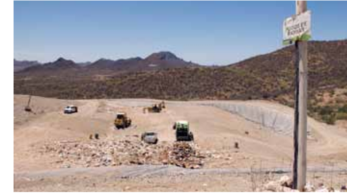
Las celdas del relleno sanitario capturan el biogas generado por la descomposición de los residuos, el cual en grandes cantidades puede ser utilizado con fines domésticos e industriales.
